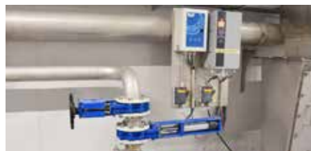
Les vannes guillotine AVK à actionneur linéaire ont été sélectionnées, car elles consomment moins d'énergie que les actionneurs à air comprimé.
